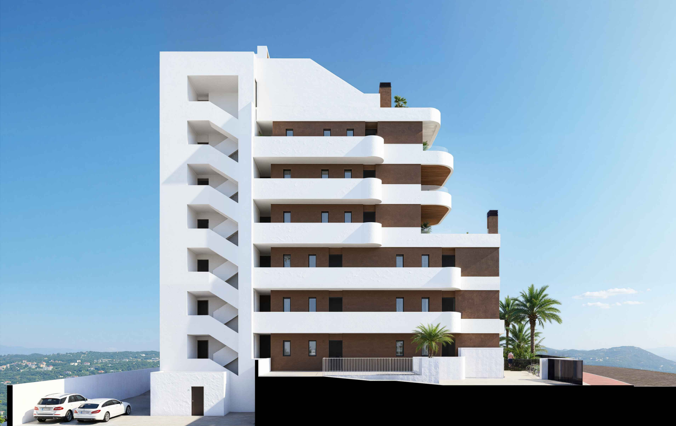
19 VIVIENDAS EN GUARDAMAR DEL SEGURA
